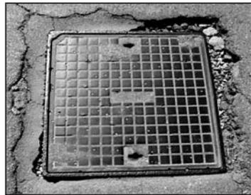
ci sono cunette, ma quello che più mi interessa è che non ci hanno incorporati con l'asfalto ma ci hanno saldati con cemento.
